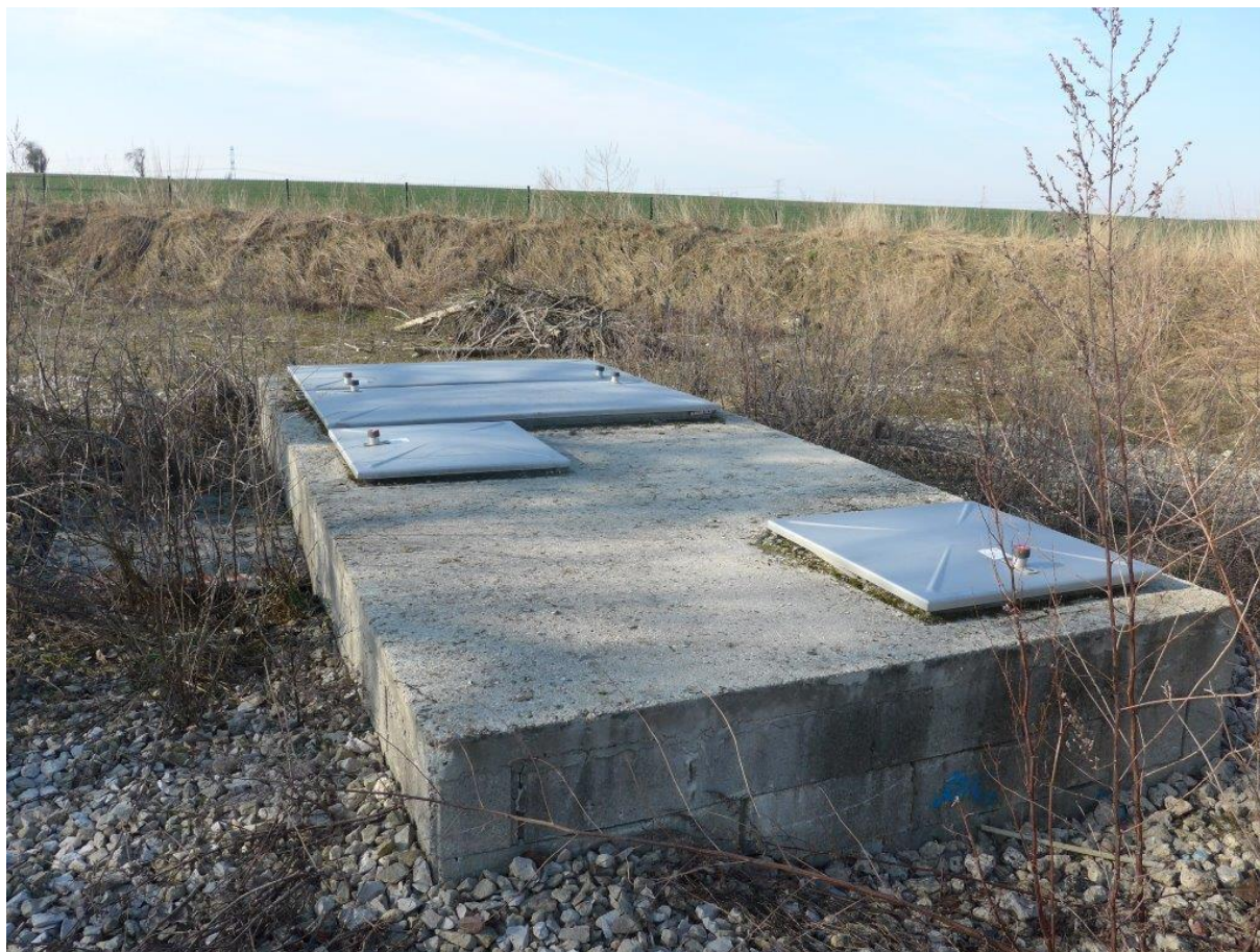
Photo 1 : Regard du forage
