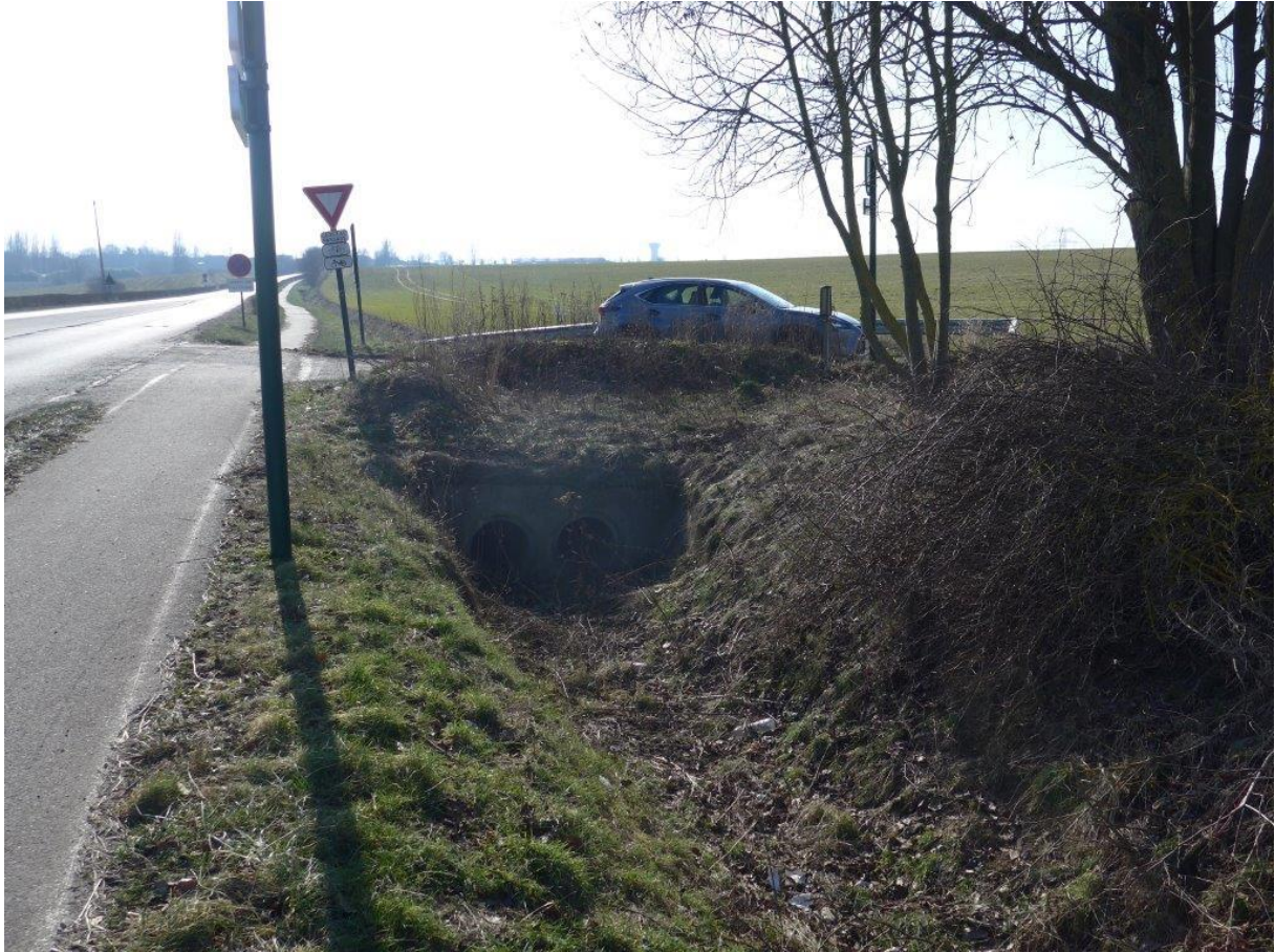
Photo 6 : Fossé le long de la route en direction de l'Est
