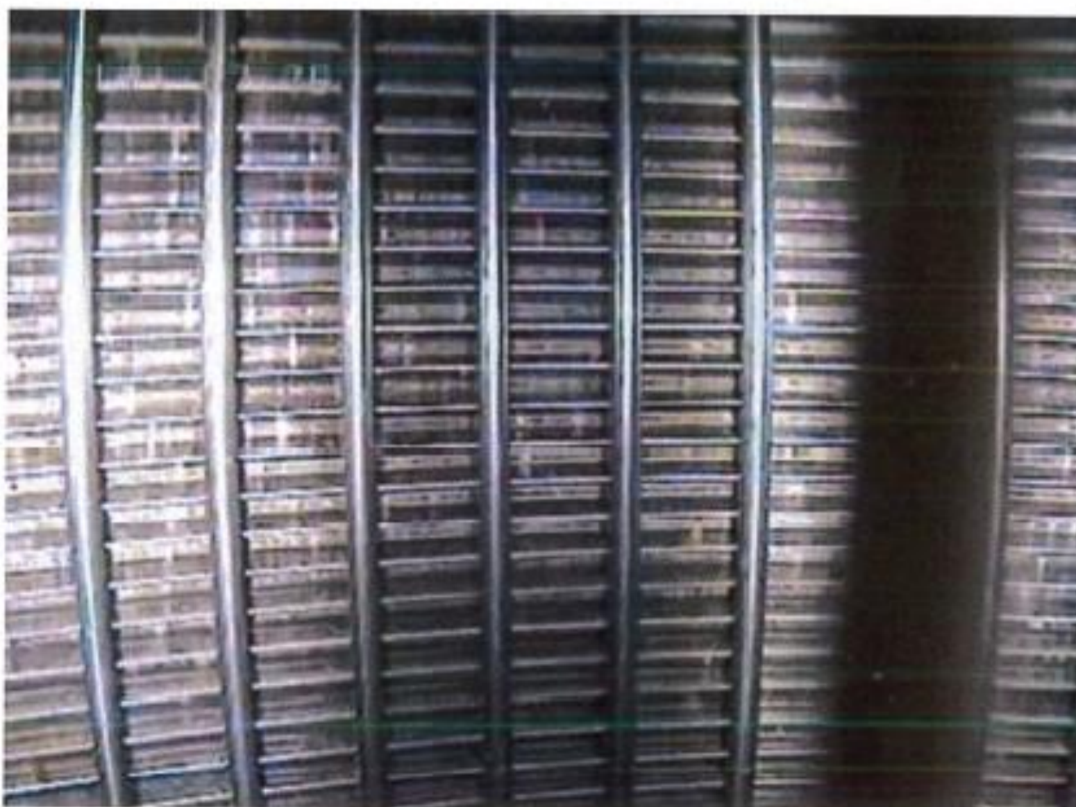
8- Tubage inox crépiné (67.75 m) – fentes ouvertes, observation du massif filtrant
